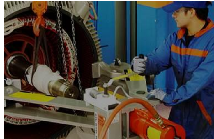
PRUEBA DE EQUIPOS
